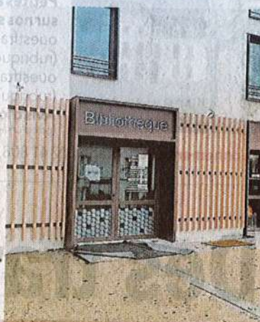
Le pôle culturel, la bibliothèque et l'espace Microfolie, place de l'Araucaria. PHOTO: CO
