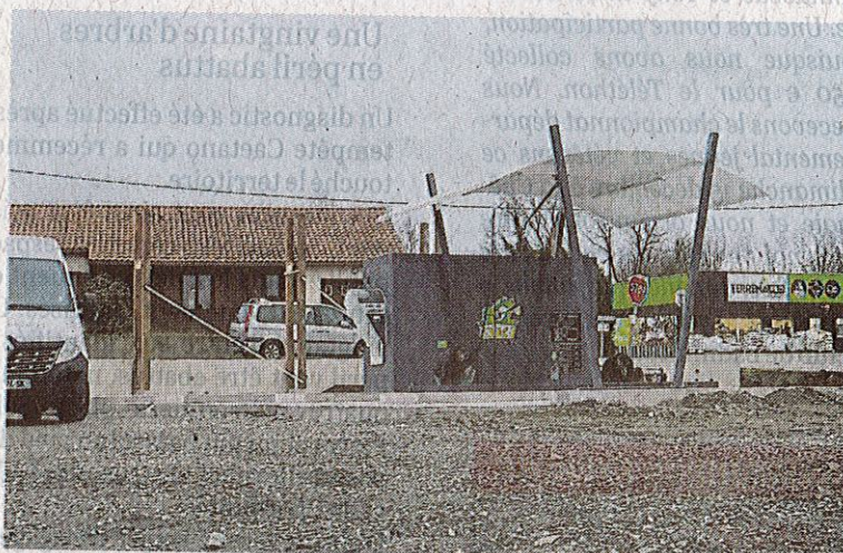
La station de lavage est sortie de terre.
