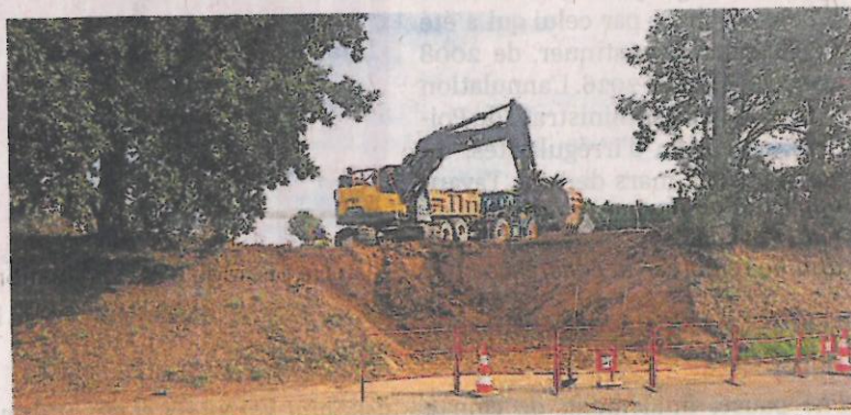
Le chantier du lotissement Les Frênes a commencé début septembre.
