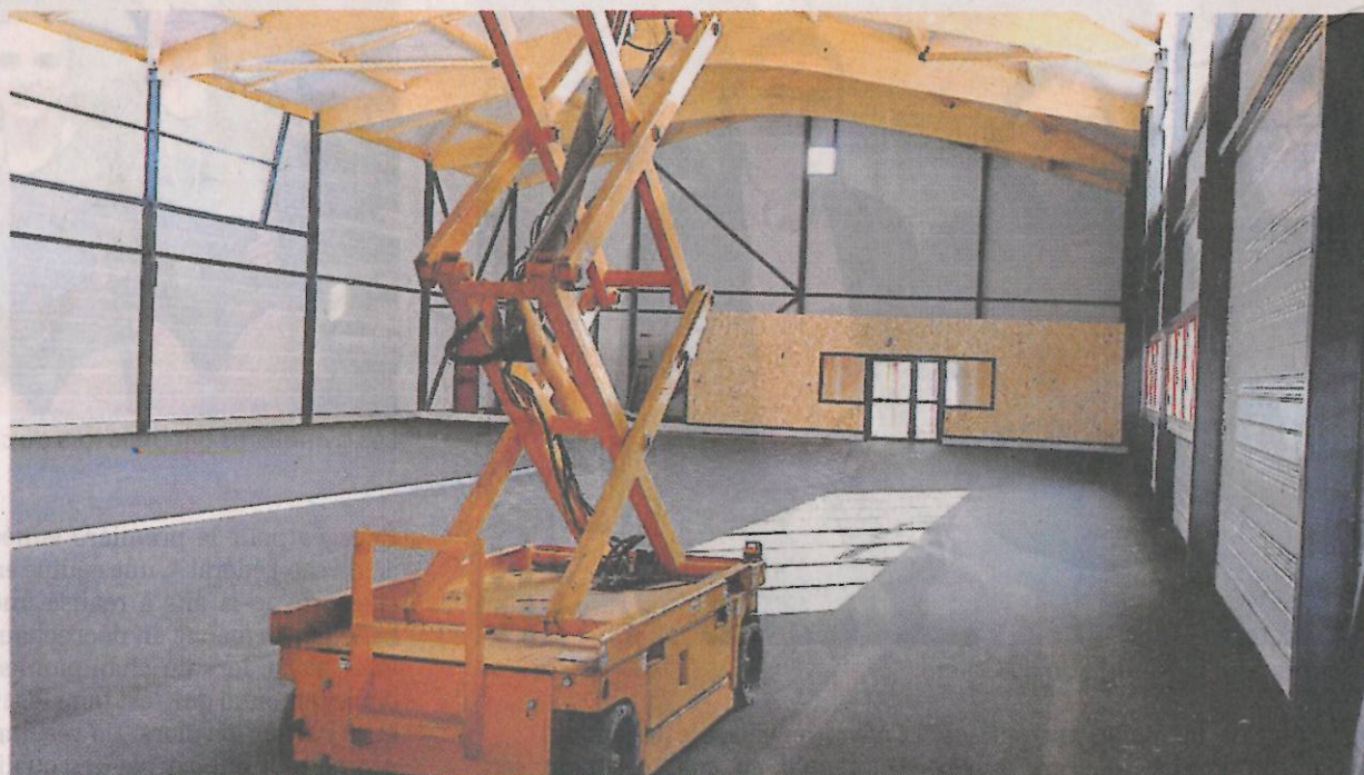
La nouvelle halle de sport, à Saint-Pardoux, sera équipée d'équipements sportifs destinés aux élèves.
