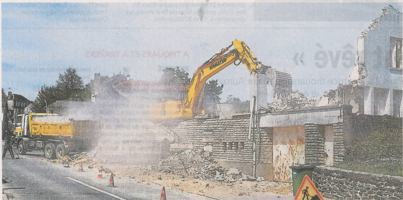
La démolition de l'ancienne Poste en avril 2022 a libéré un terrain sur lequel la commune va construire un restaurant scolaire.
